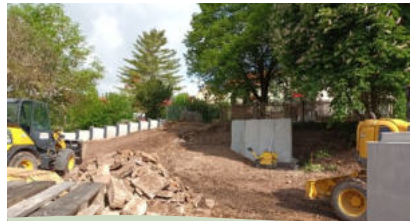
Errichtung der Stützmauer
